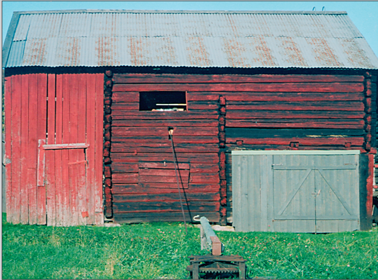
Bilde viser kjørehjulet med overføringsaksel til låven og treskeverket.
